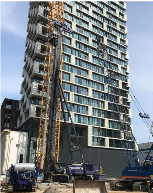
Foto 8: Het plaatsen van de palen voor woontoren Fase 3B/3C.
