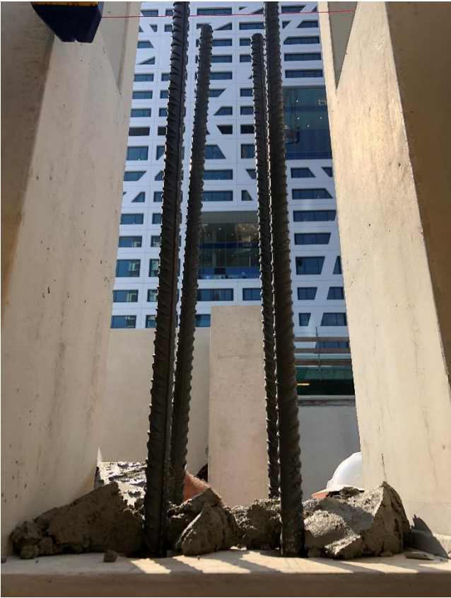
Afbeelding 5: Voorbereiding voor het plaatsen van geprefabriceerde beton.
