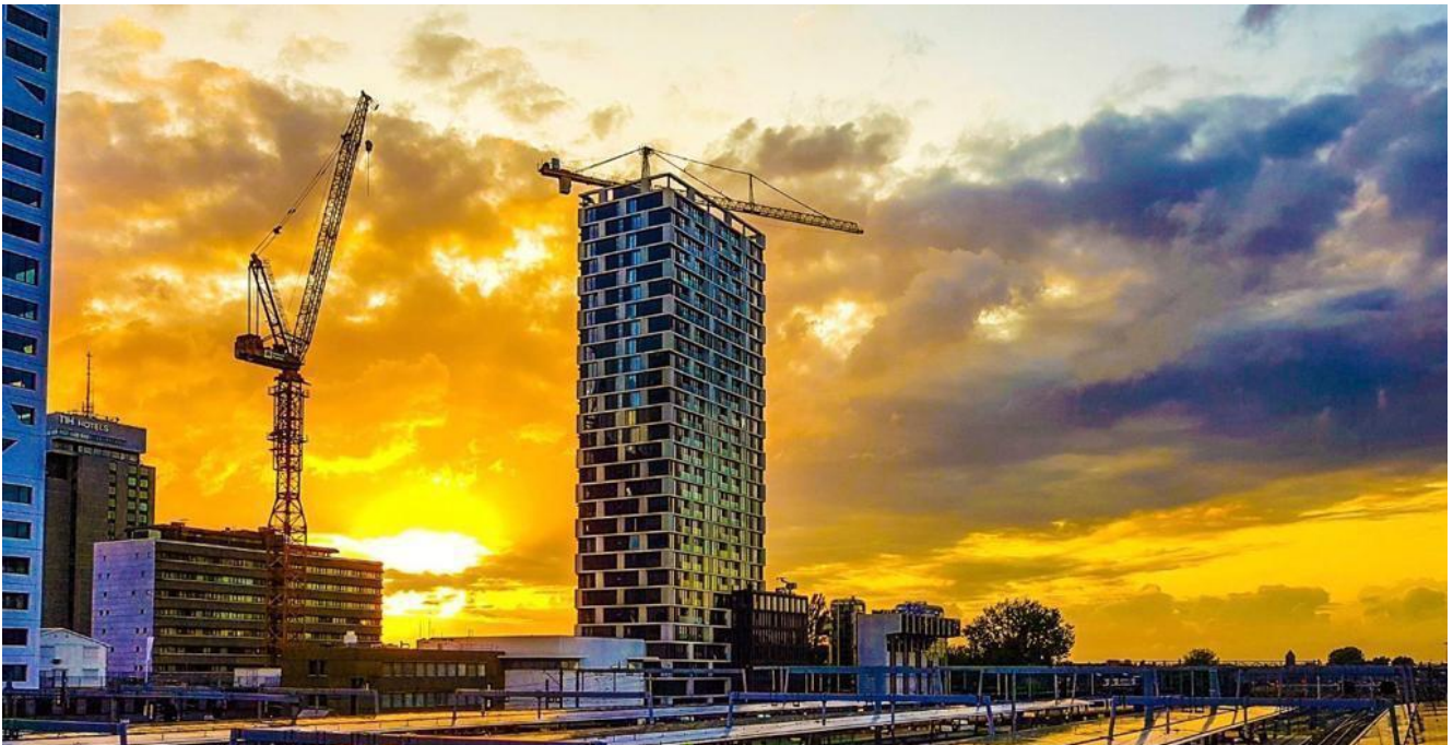
Afbeelding 1: Een foto van de bouwplaats vanaf Utrecht Centraal Station.
