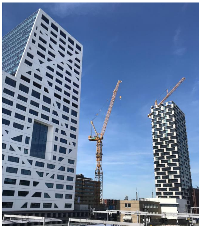
Afbeelding 8: Het Stads kantoor en De SYP met daartussen de bouwplaats van Bouwcombinatie Westflank Noord.
