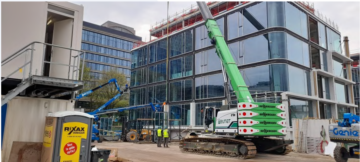
afbeelding 1 montage gevelelementen PI59
