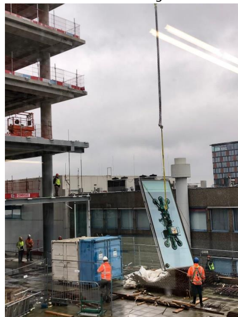
Afbeelding 2: Het plaatsen van gevelelementen.
