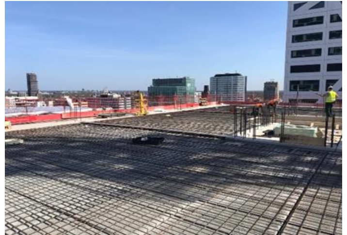
Afbeelding 1: De vloer van de 11 e verdieping is klaar voor het storten van het beton.
